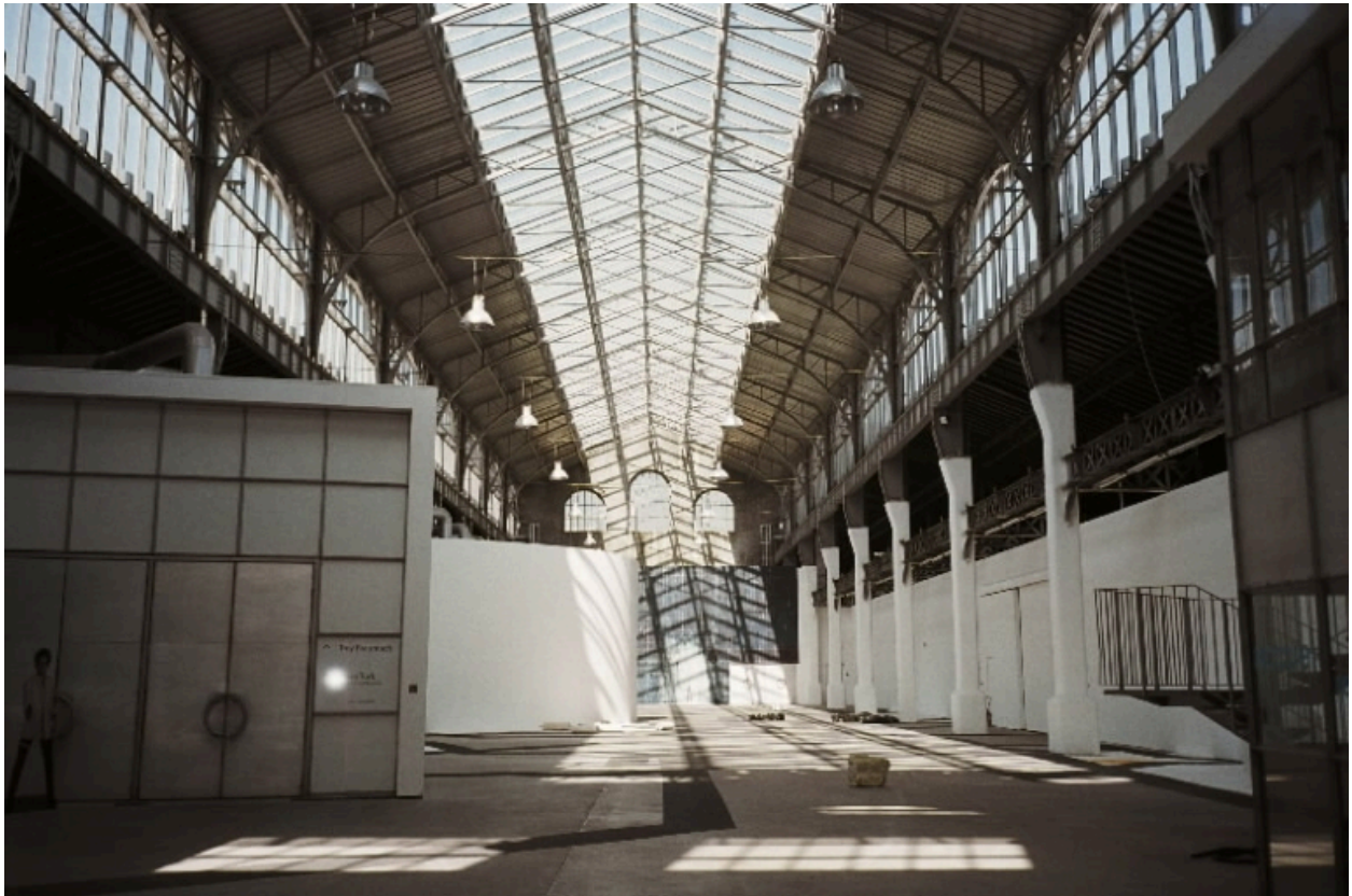
Vue intérieure du bâtiment
