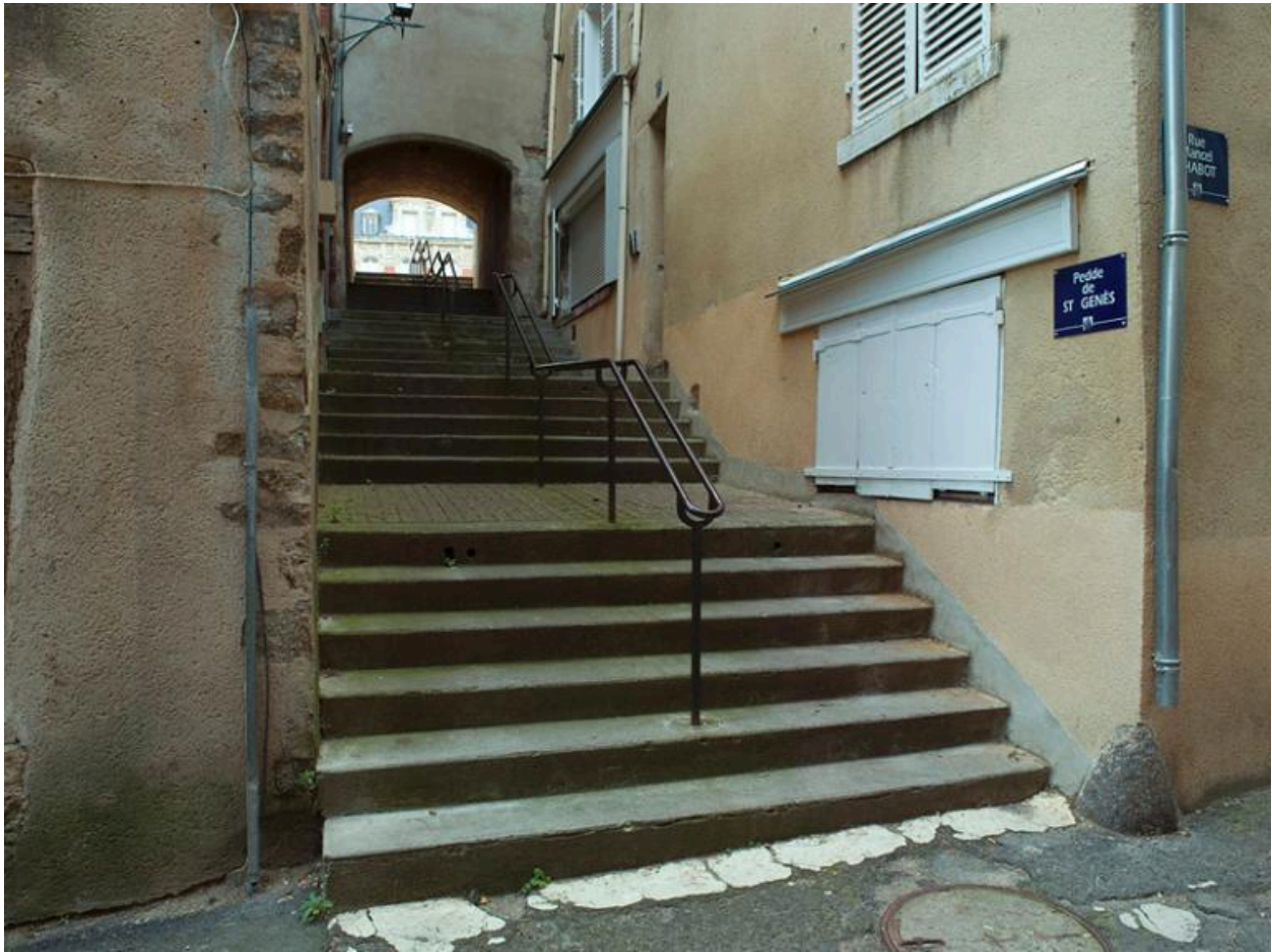
Les escaliers de la pedde depuis la rue Mancel-Chabot.
