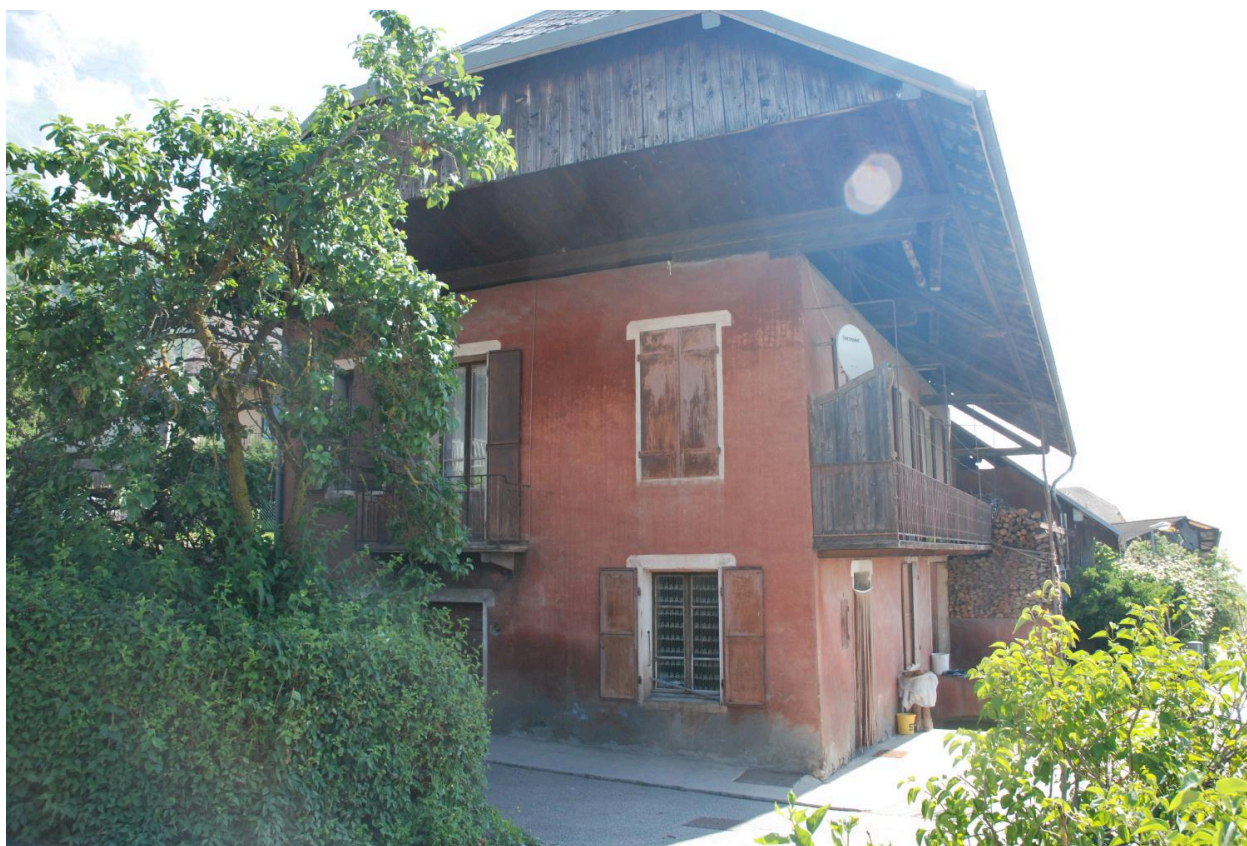
Maison (2018 C2 1176). Extension en charpente sous le débord de toiture.
