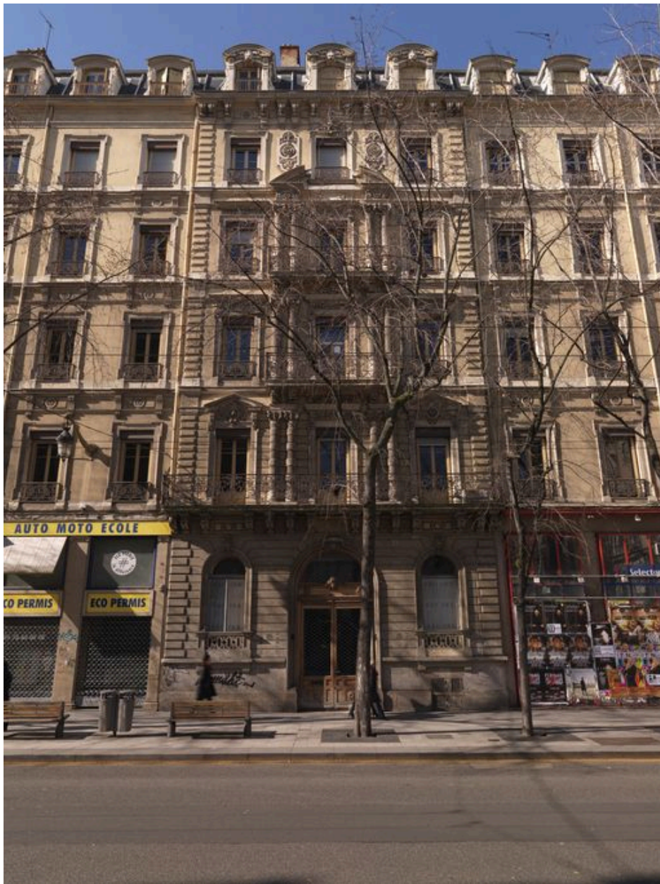
Vue de la travée centrale de l'élévation située 16 rue de la République.
