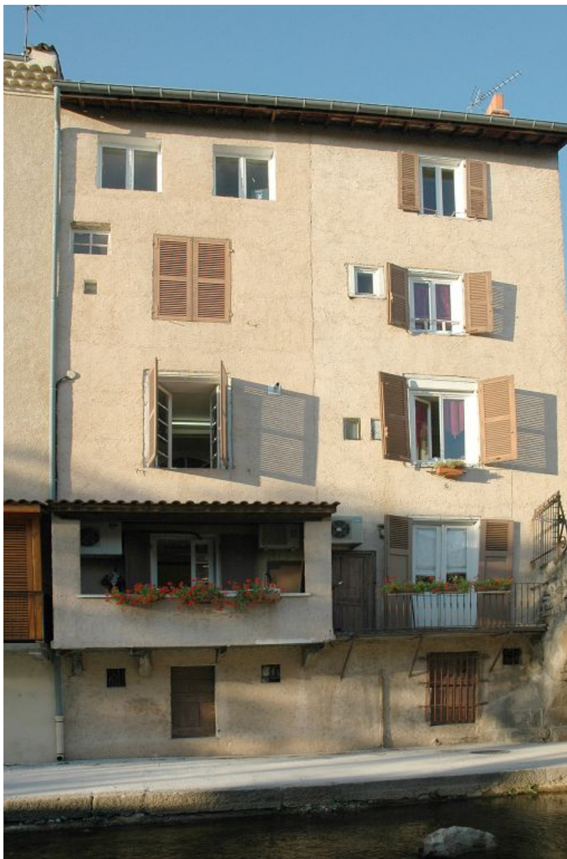
Elévation postérieure du côté de la rivière.
