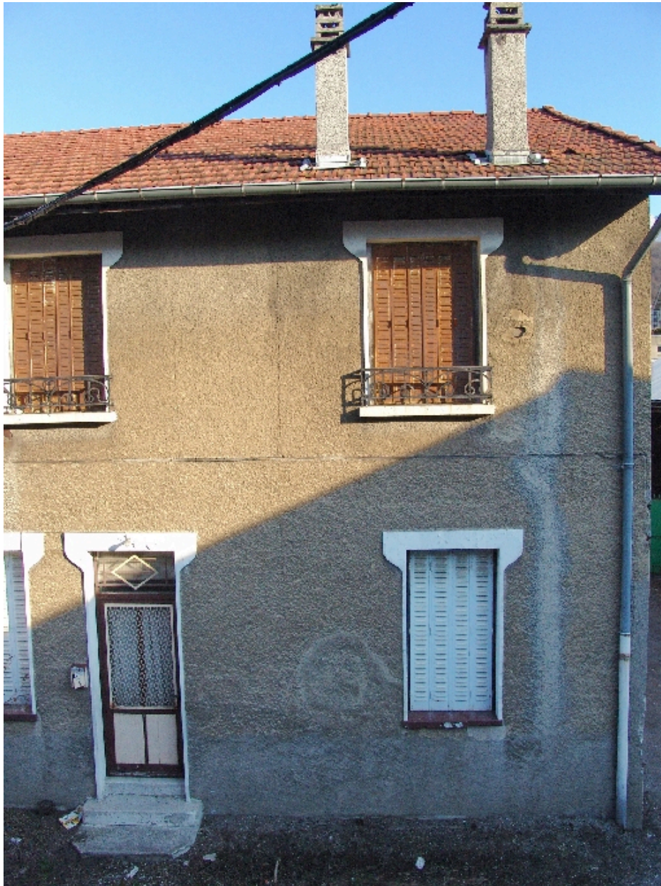
Façade du logis sud
