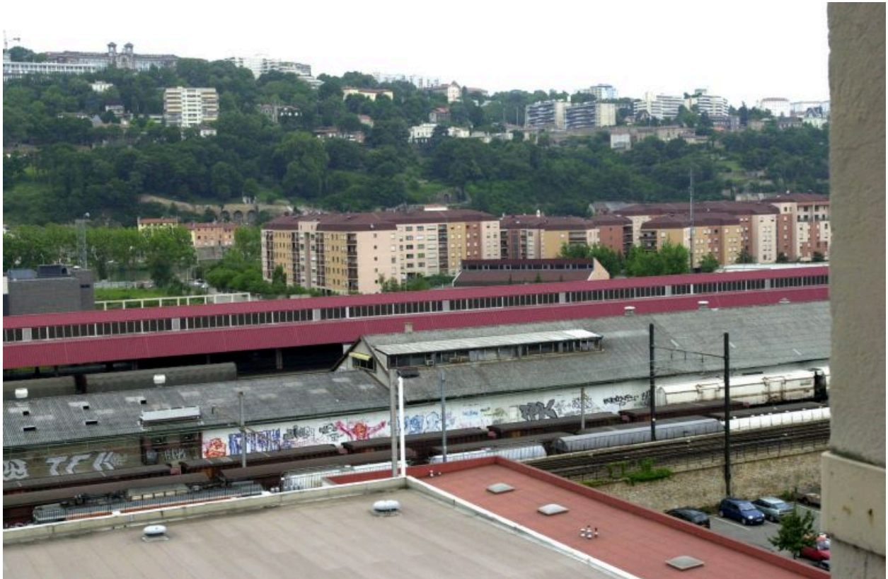
Vue d'ensemble du quai de chargement depuis le sud-est, depuis l'immeuble 82 cours Charlemagne
