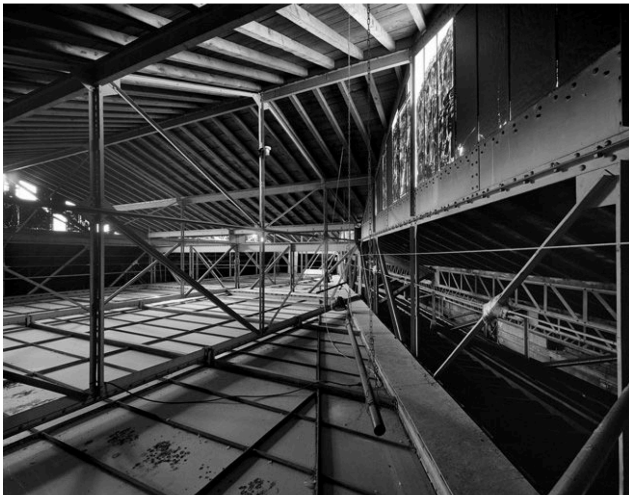
Grande salle, ancienne patinoire : la charpente métallique
