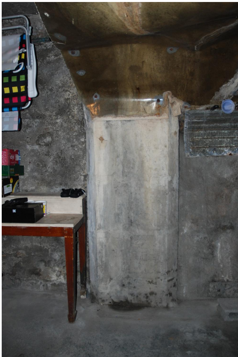
Vue intérieure des vestiges du collatéral est, partie sud, mur ouest : pilier adossé.
