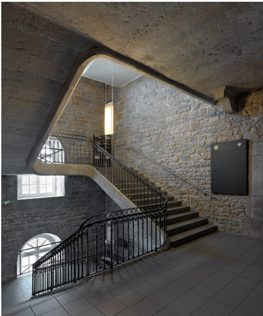
Escalier secondaire au nord.
