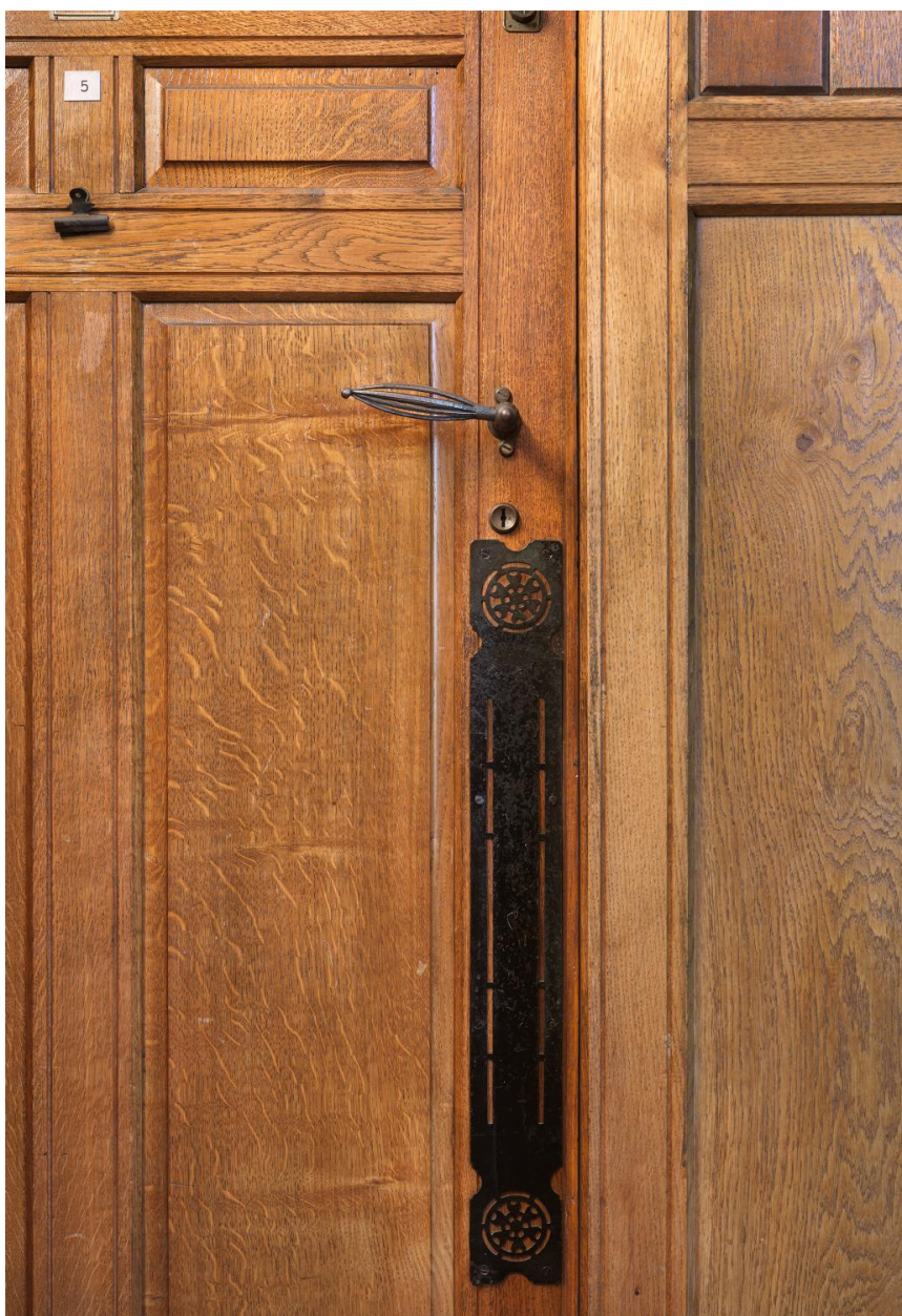
Porte, détail de ferrures
