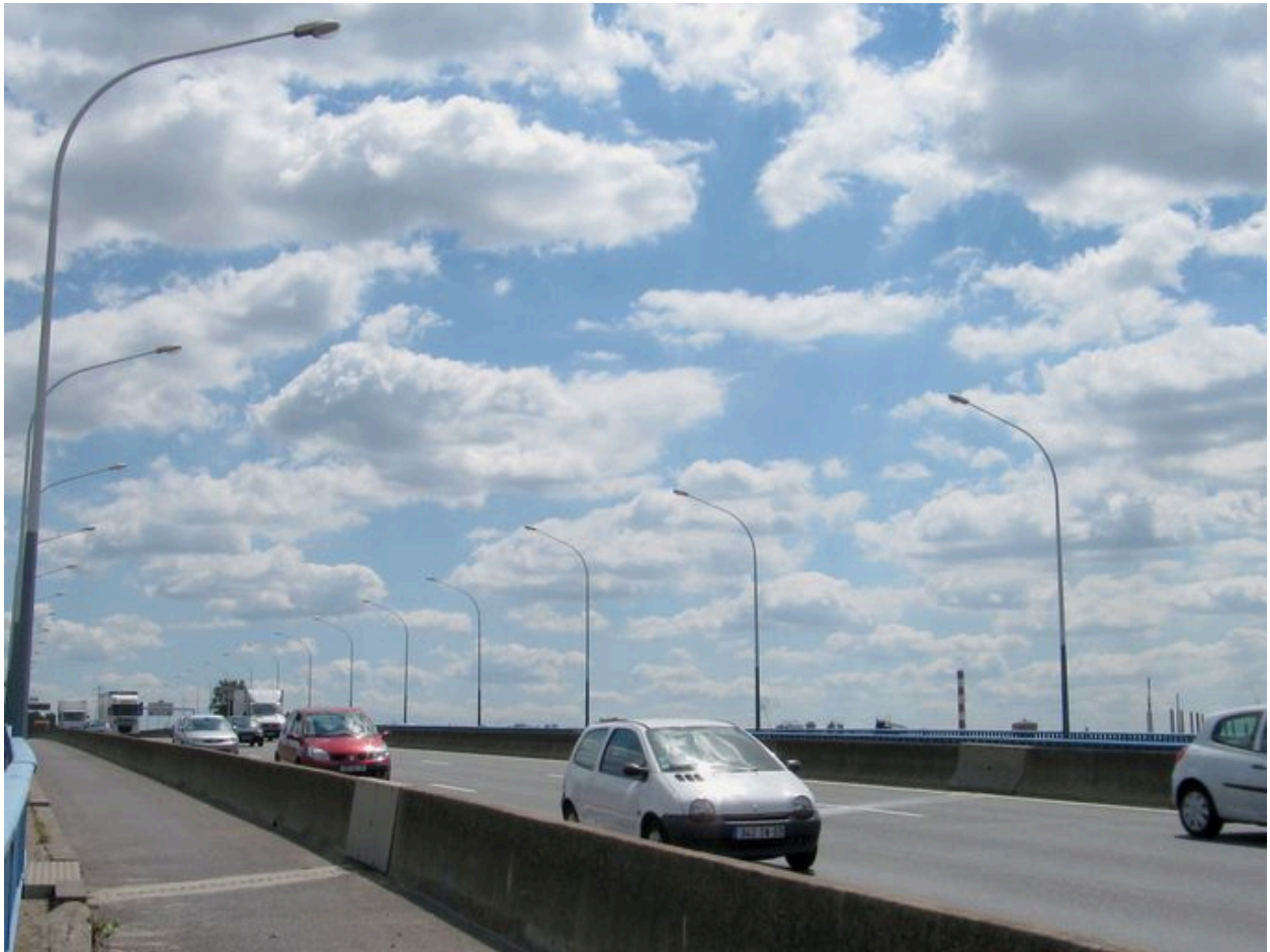
Chaussée et trottoir (depuis la rive droite)
