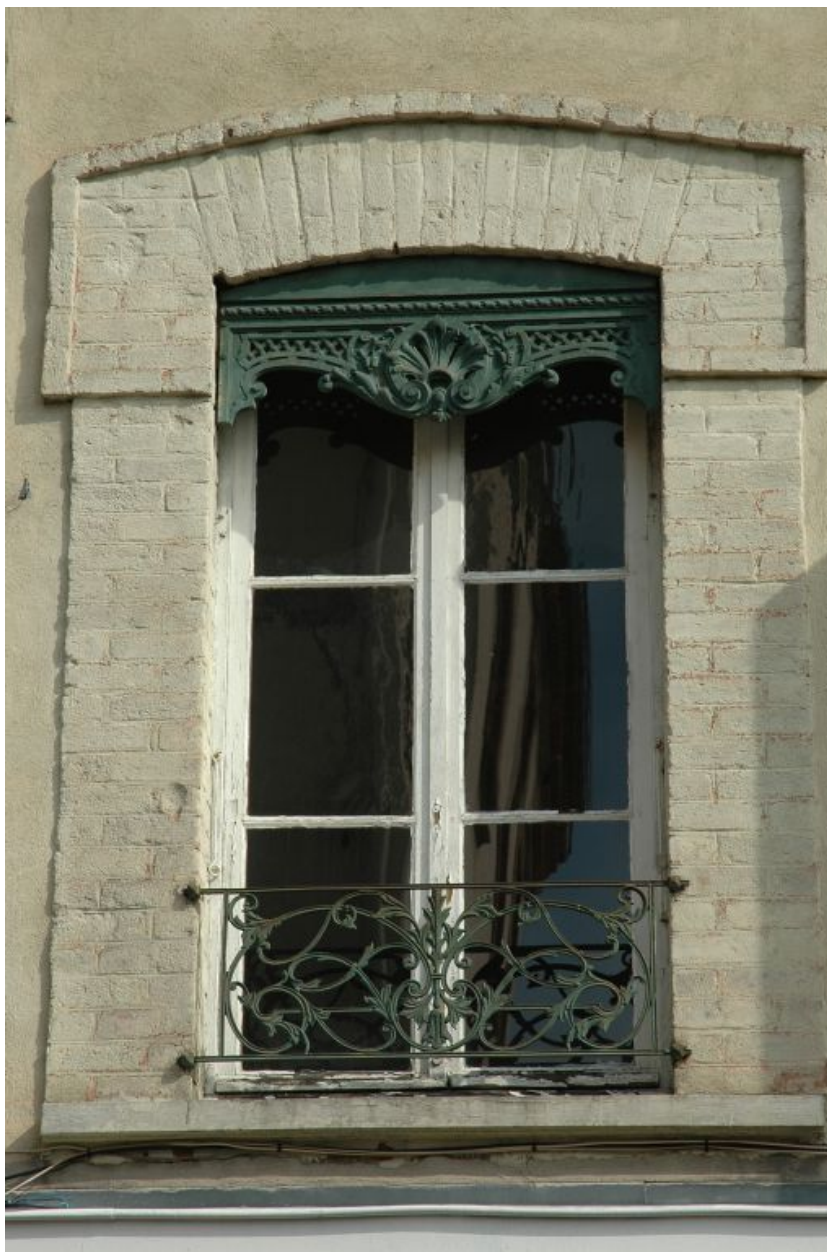
Fenêtre à encadrement de briques, ornée d'un lambrequin et d'un garde-corps en fonte.
