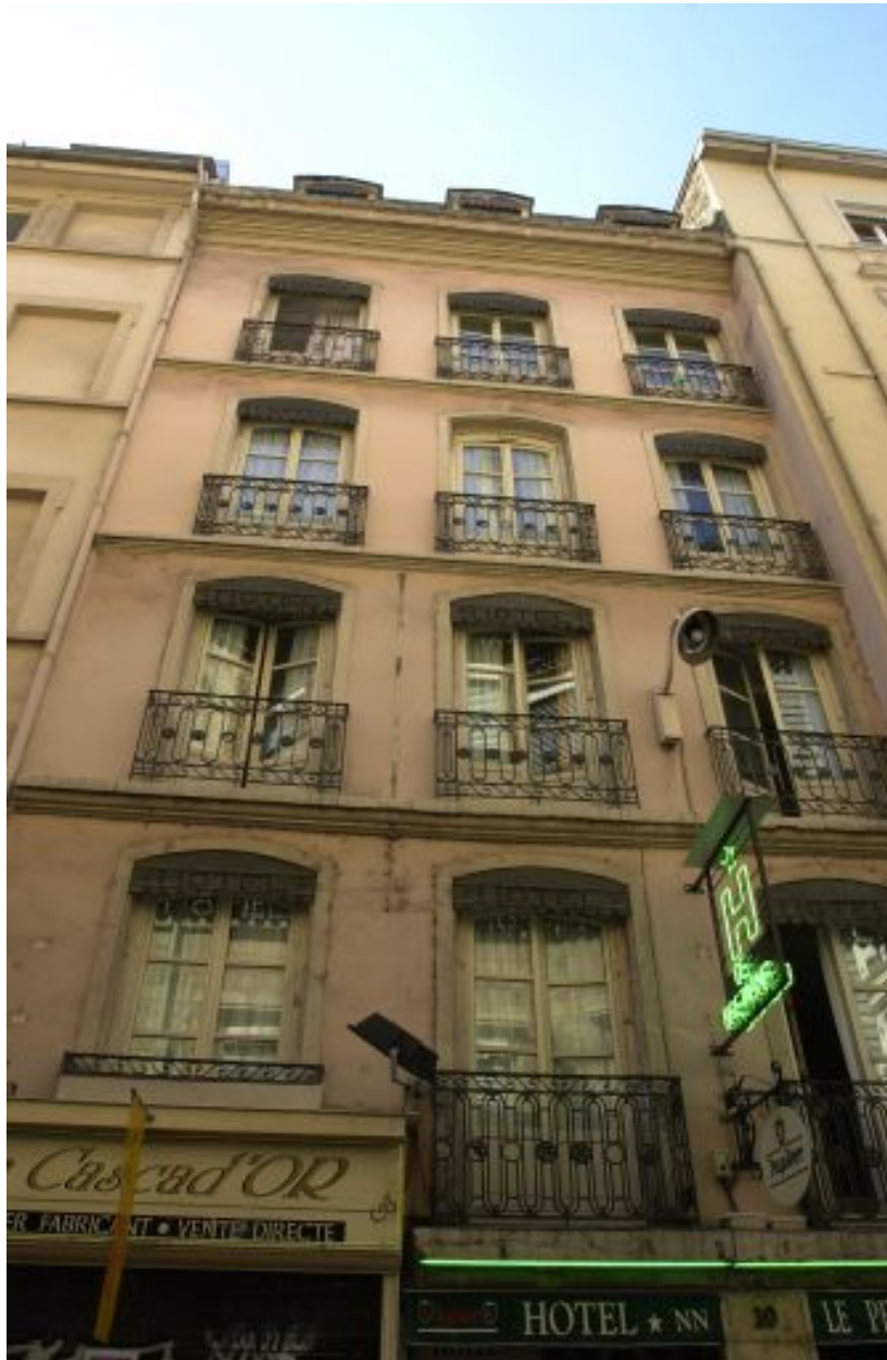
Façade, vue générale par-dessous
