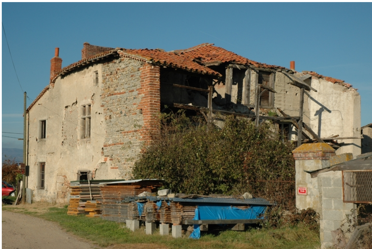
Vue générale du logis, depuis le sud-est (état en 2006)
