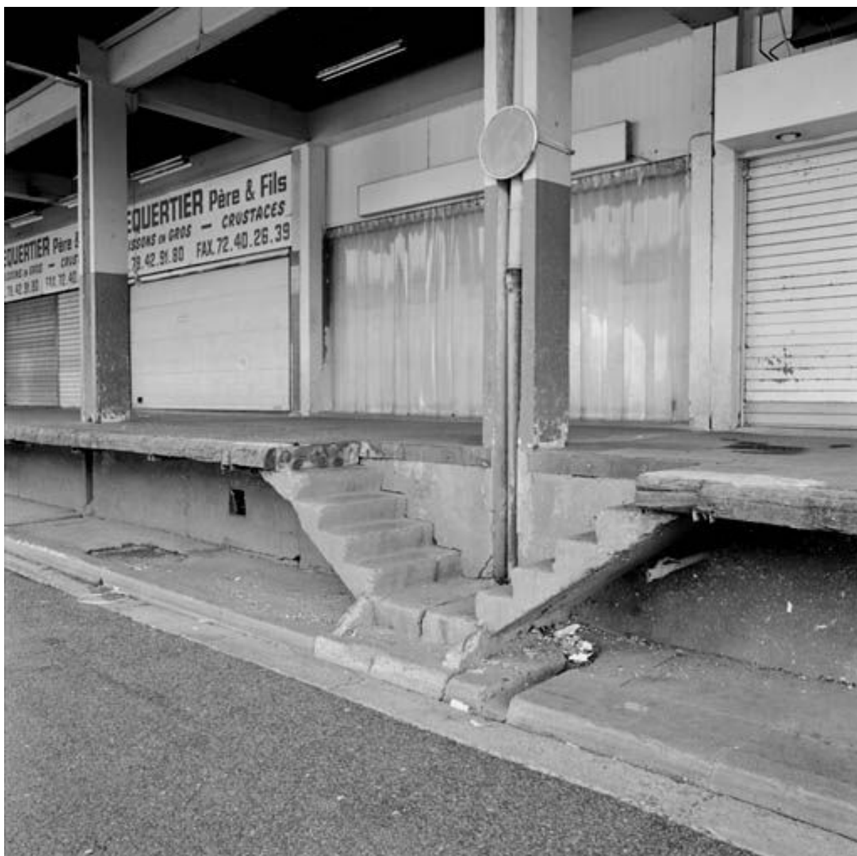
Allée latérale ouest : escalier menant au quai de déchargement
