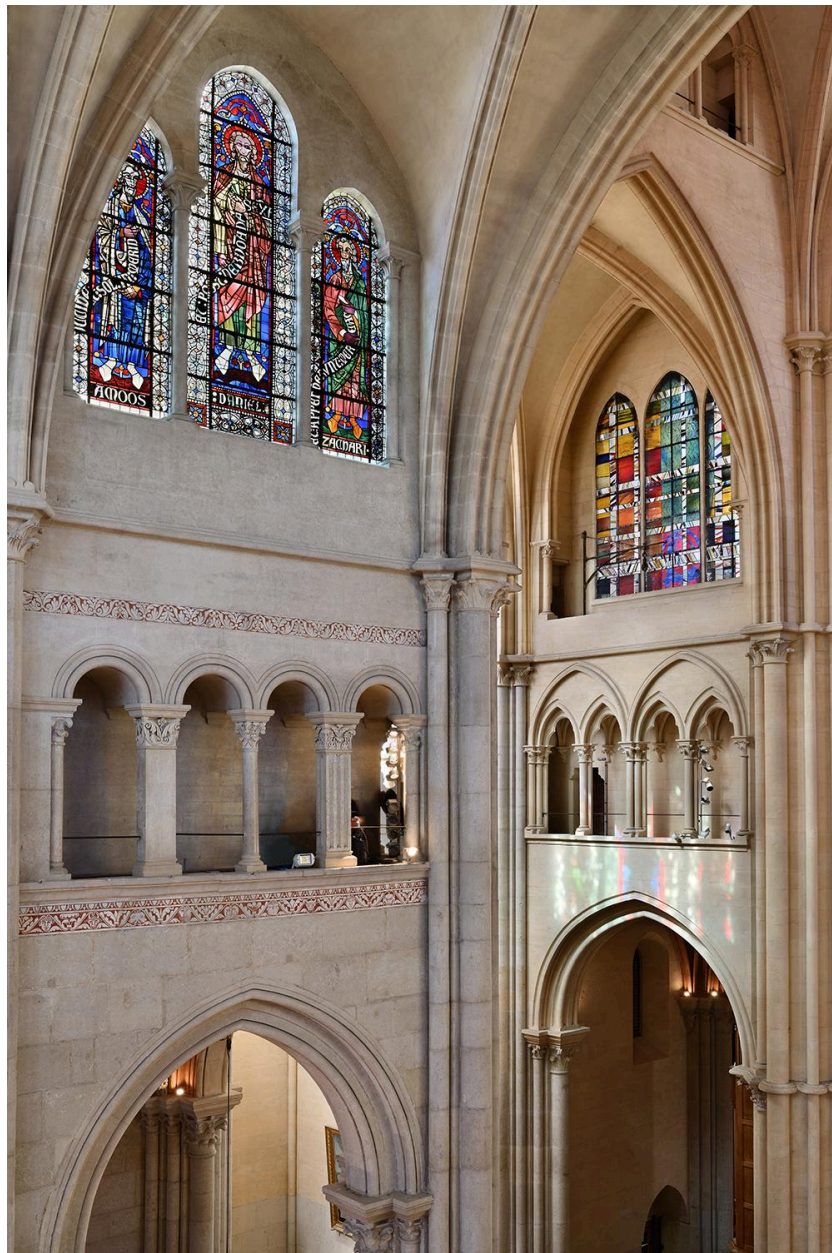
Travée droite du chœur et transept sud depuis le triforium : parties hautes
