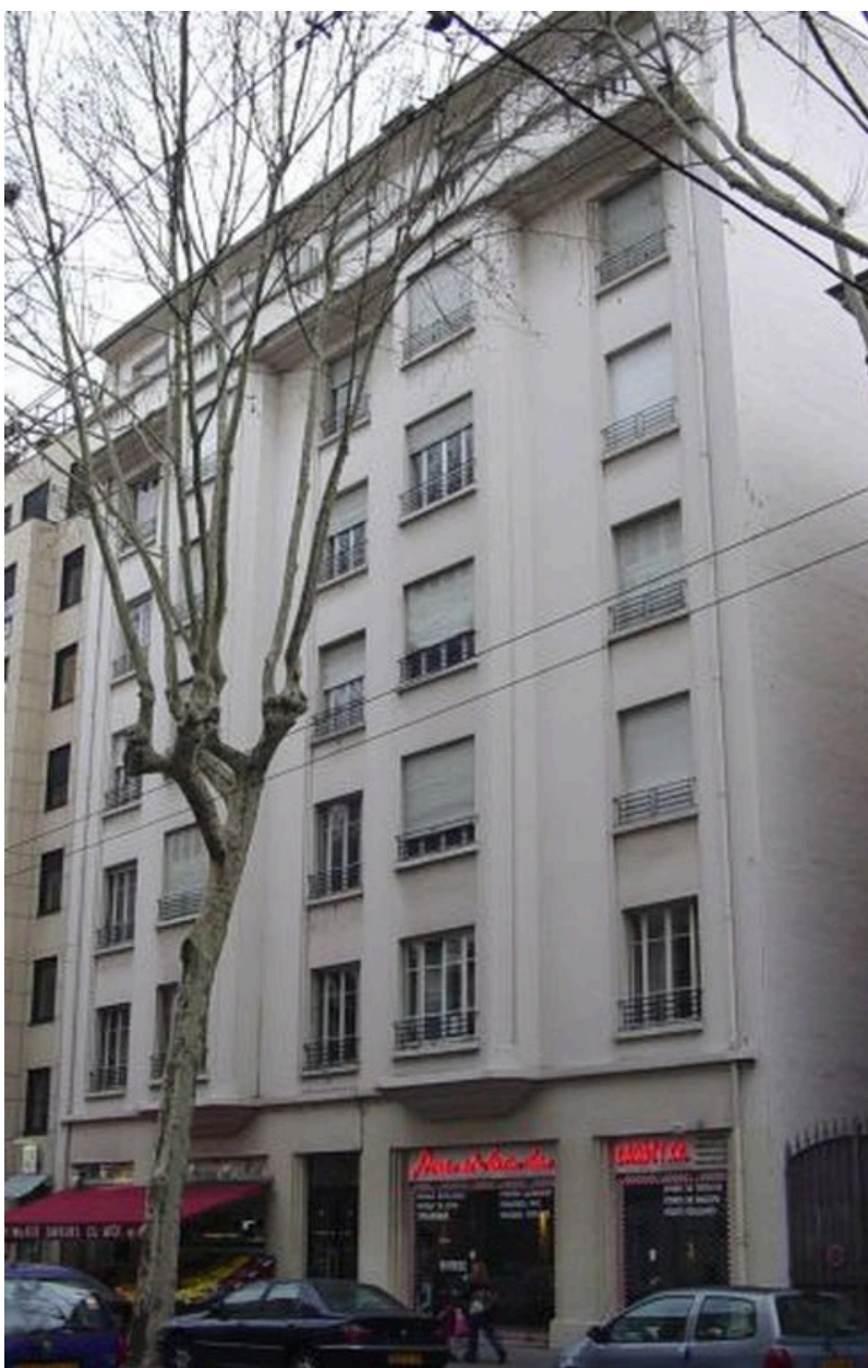
Vue générale de l'élévation
