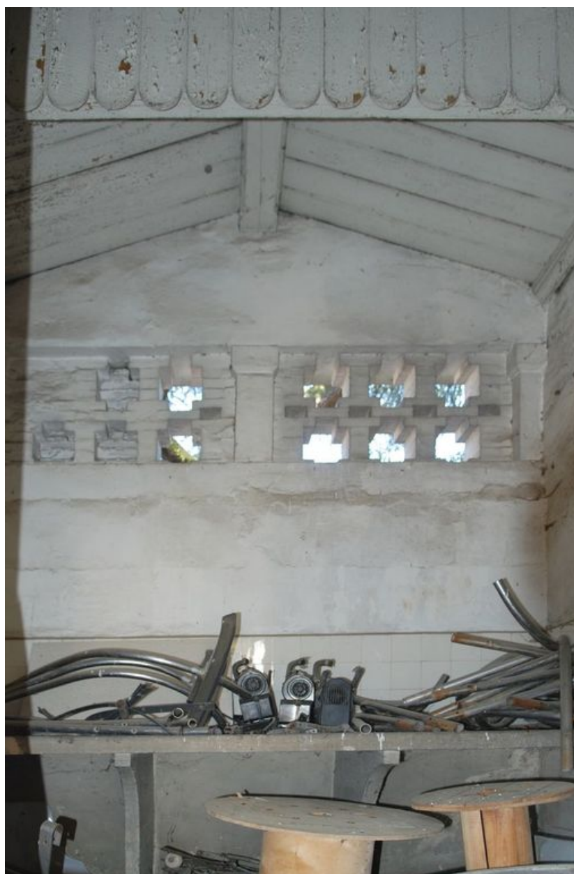
Petit édicule (sanitaires ?) situé à l'extrémité du portique menant à l'angle nord-ouest du bâtiment 504
