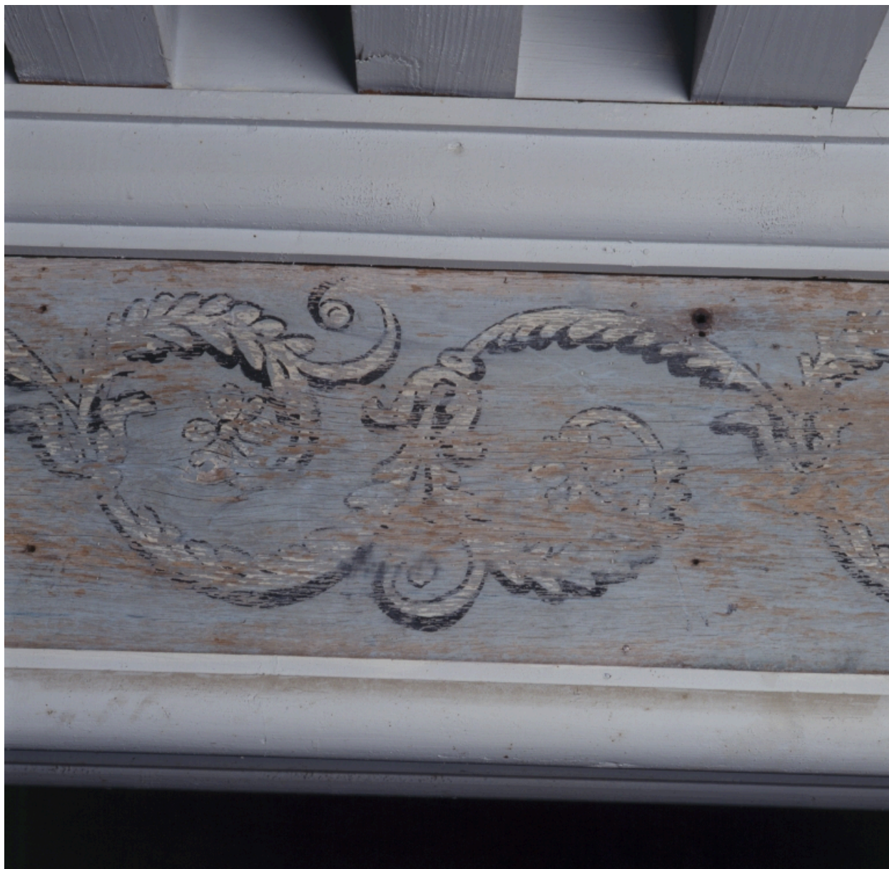
Corps de logis nord-est, premier étage, salle dite du Grand Juge située au nord : détail intérieur des rinceaux peints sur les poutres.
