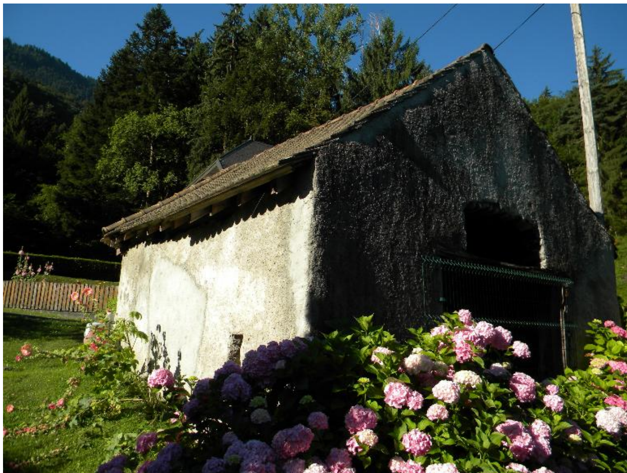
Vue d'ensemble du four.
