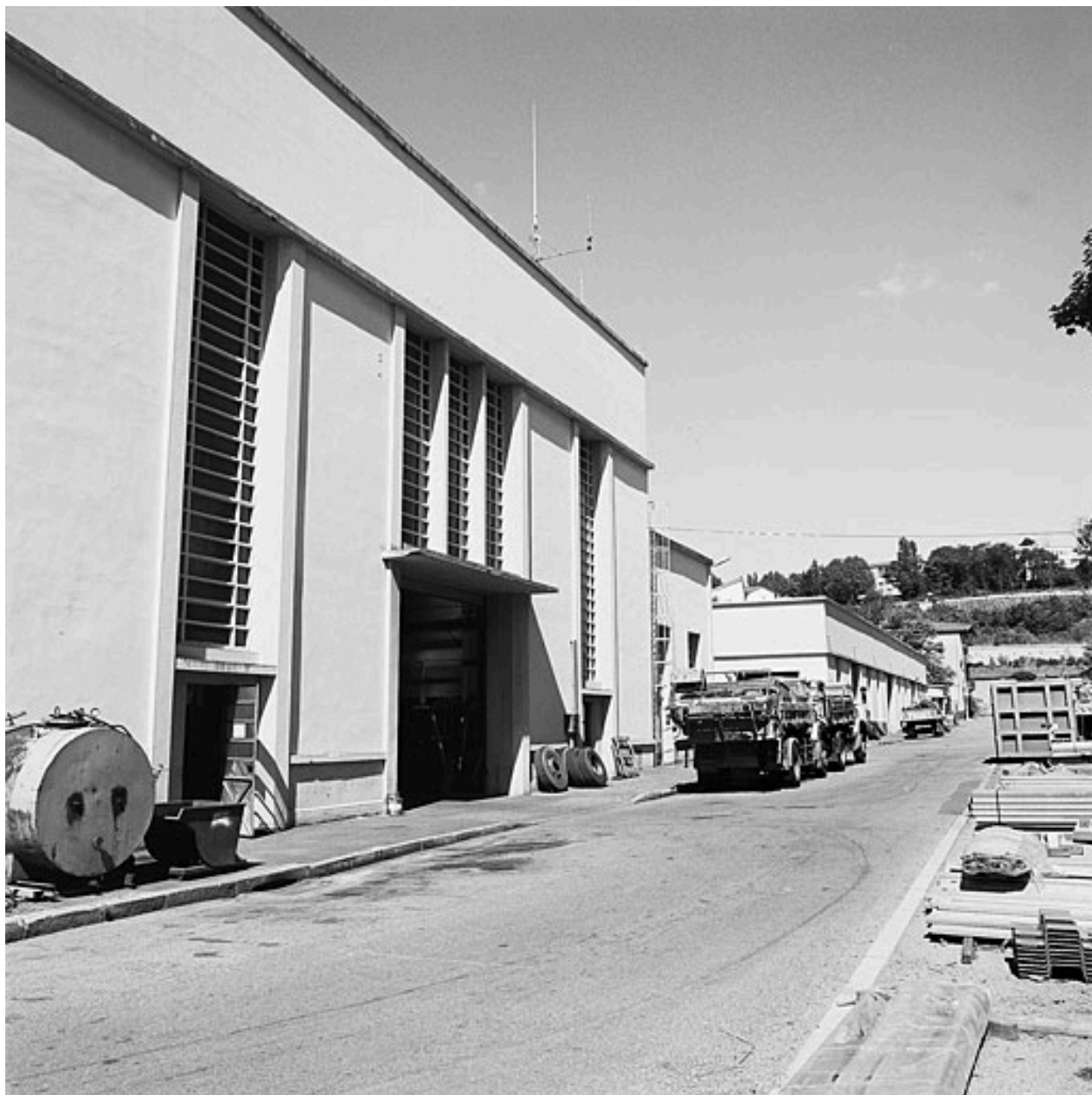
Vue de la façade nord
