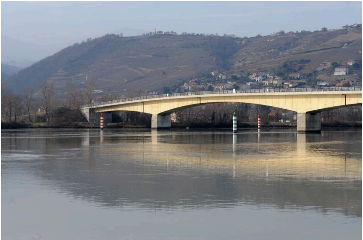
Vue partielle, culée et travées dextres, face aval (depuis la rive gauche)
