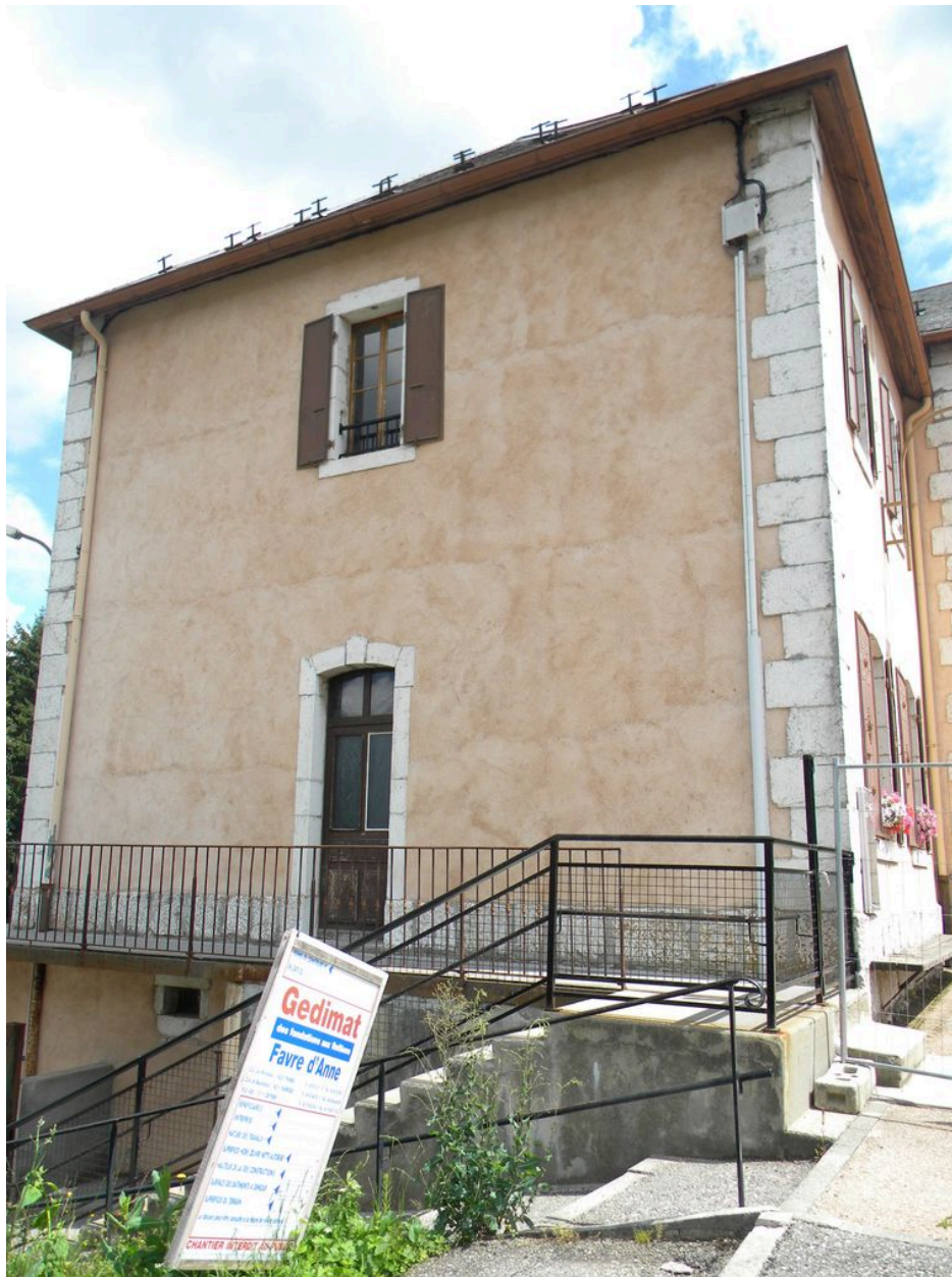
Vue de la façade ouest.
