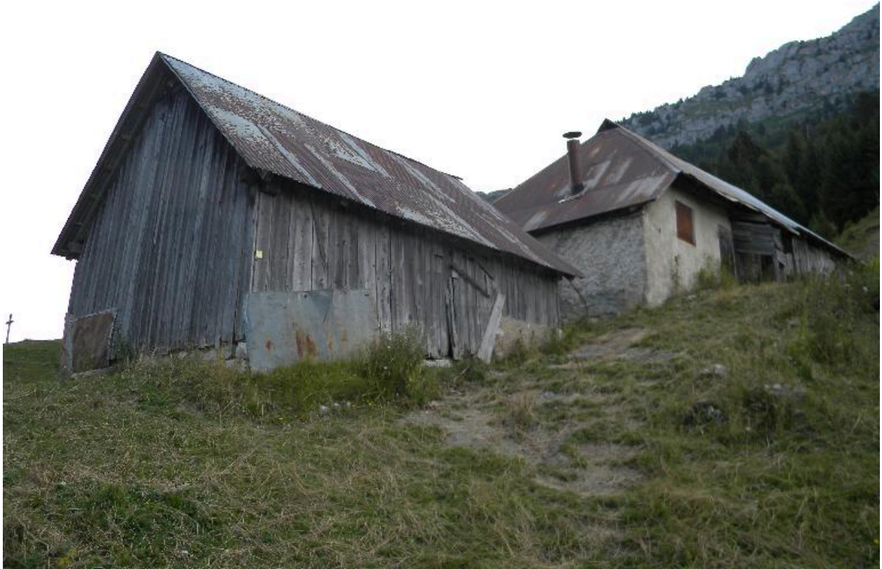
Vue d'ensemble des bâtiments amont.
