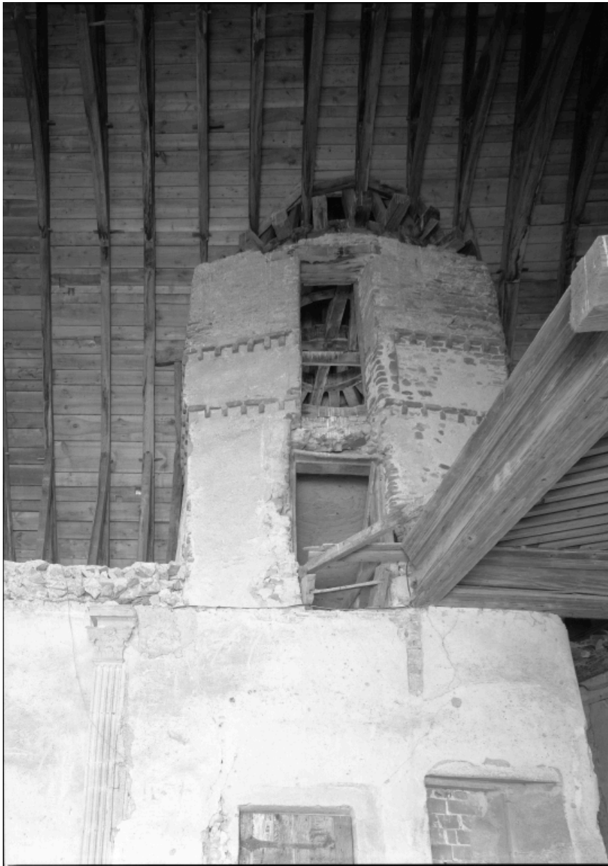
Corps de logis, deuxième étage, cinquième pièce (d'est en ouest) : vue de la tour d'escalier, du nord.
