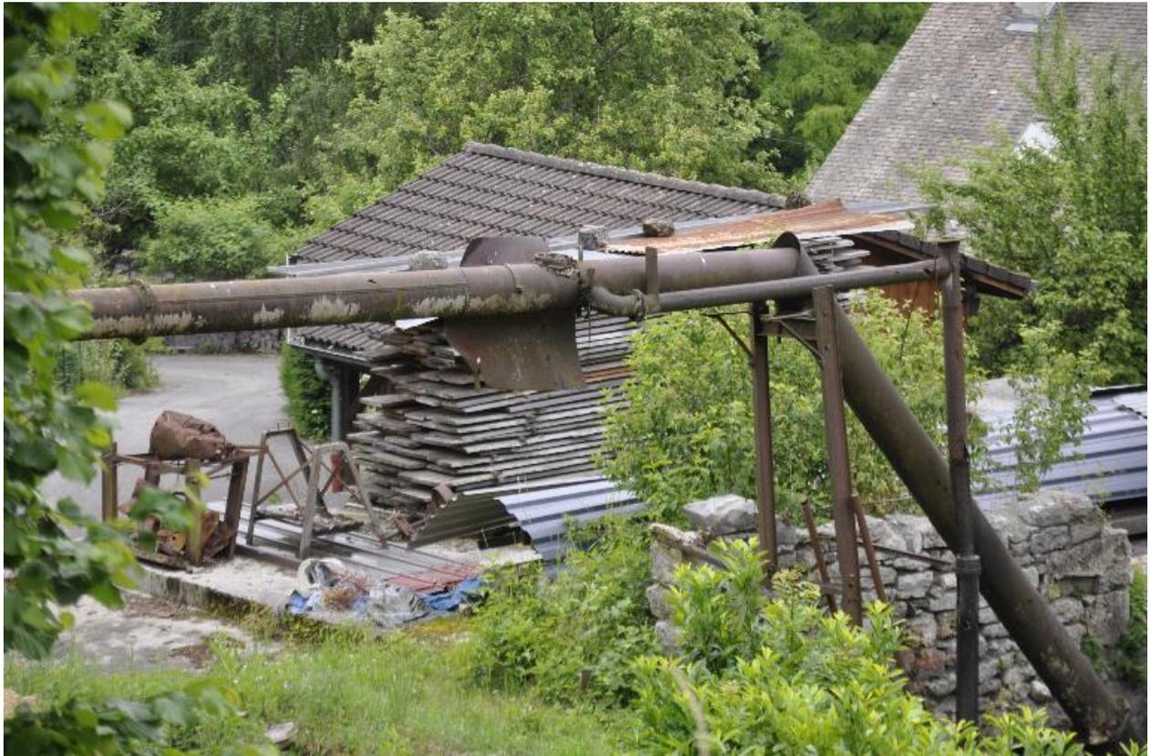
Conduite forcée coudée partant en direction de la roue hydraulique
