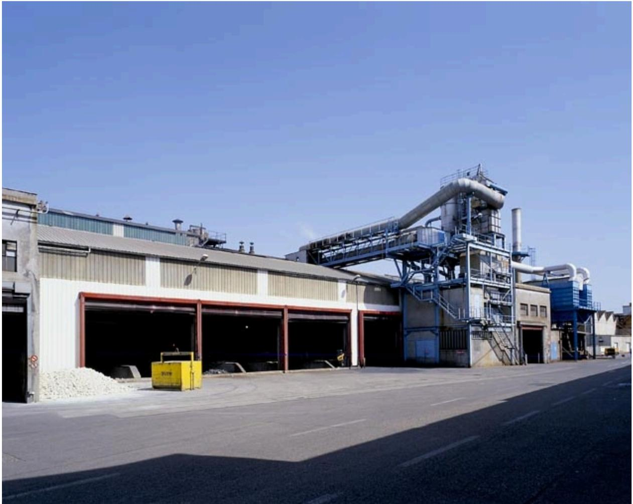
Fonderie BC1, unité de dépoussiérage du cubilot et quatre fosses d'alimentation en coke et minerai du cubilot.
