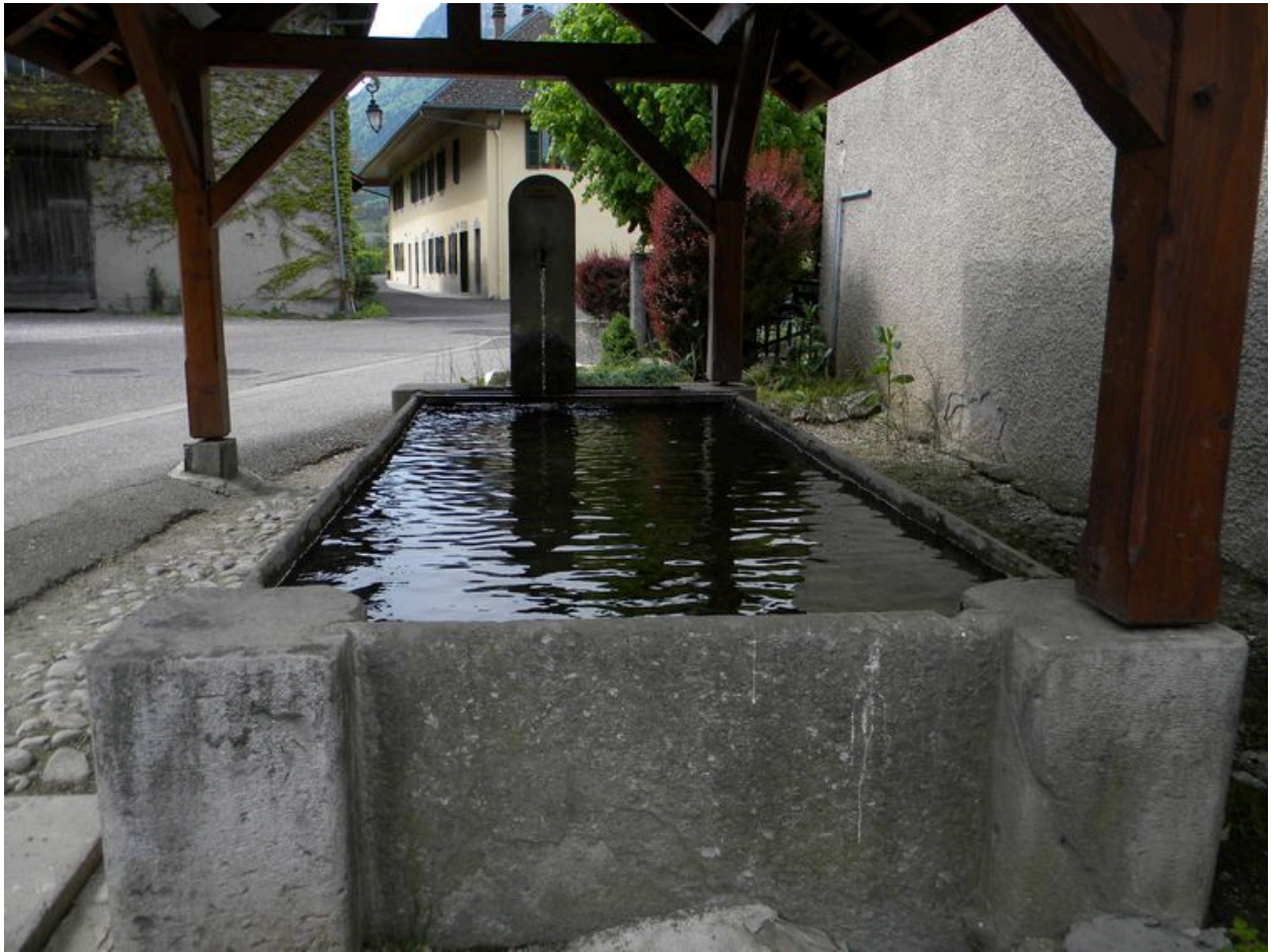
Vue du bassin de face sous sa couverture.
