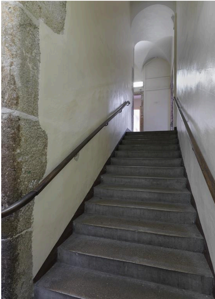
Escalier F, 1ère révolution, 2e volée
