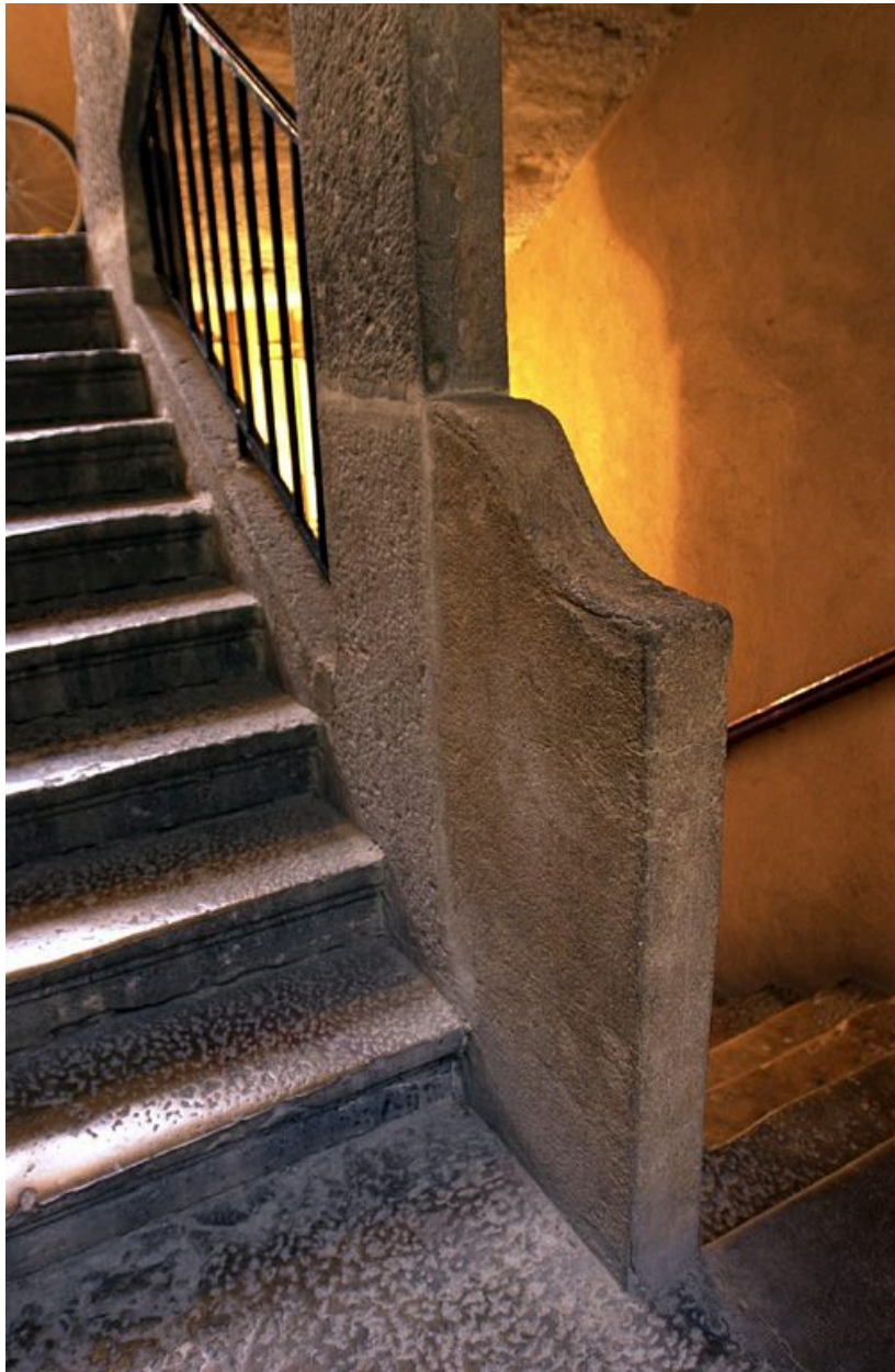
Couvent : 11 place Antonin-Gourju, détail du noyau de l'escalier
