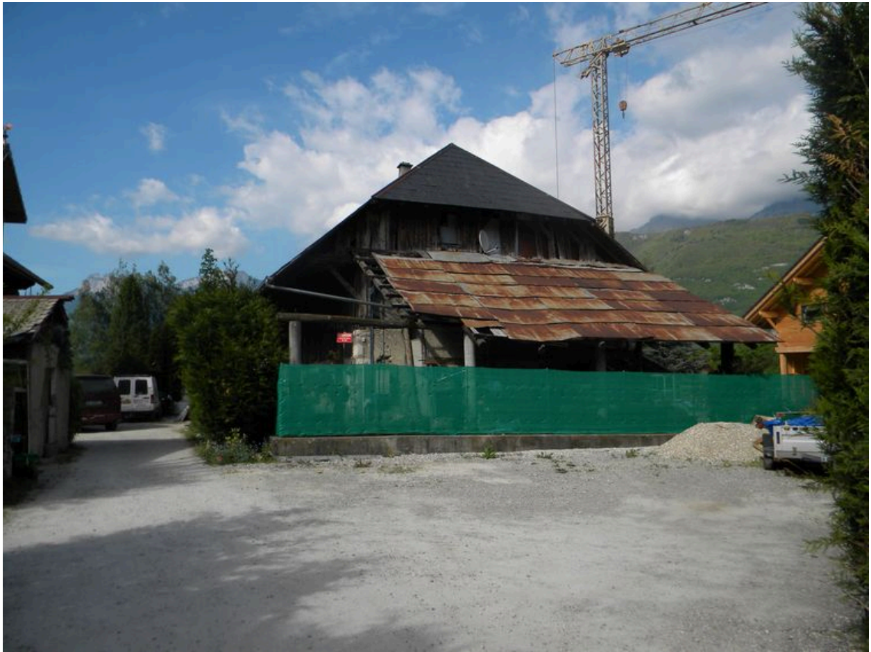
Vue du petit côté d'une ancienne ferme à juxtaposition (2008 C8 2381).
