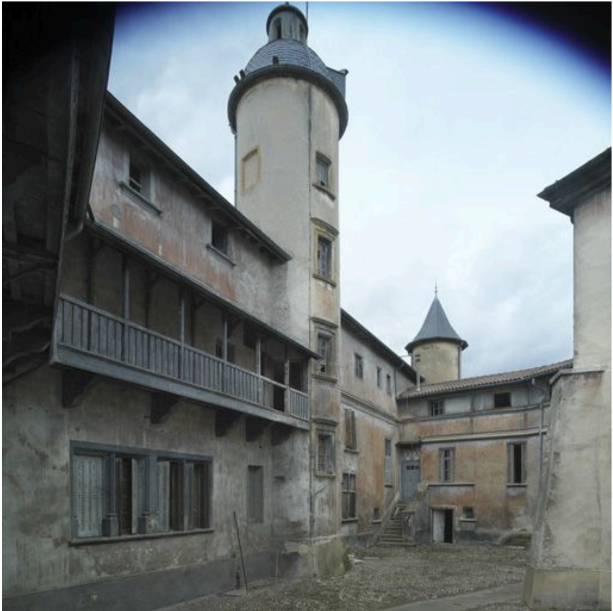
La cour depuis l'entrée au sud-est
