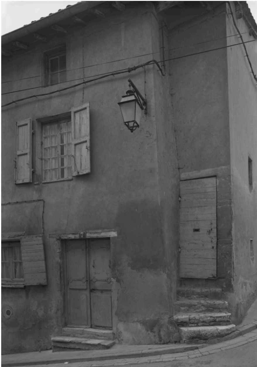
Elévation sur rue : cage d'escalier.
