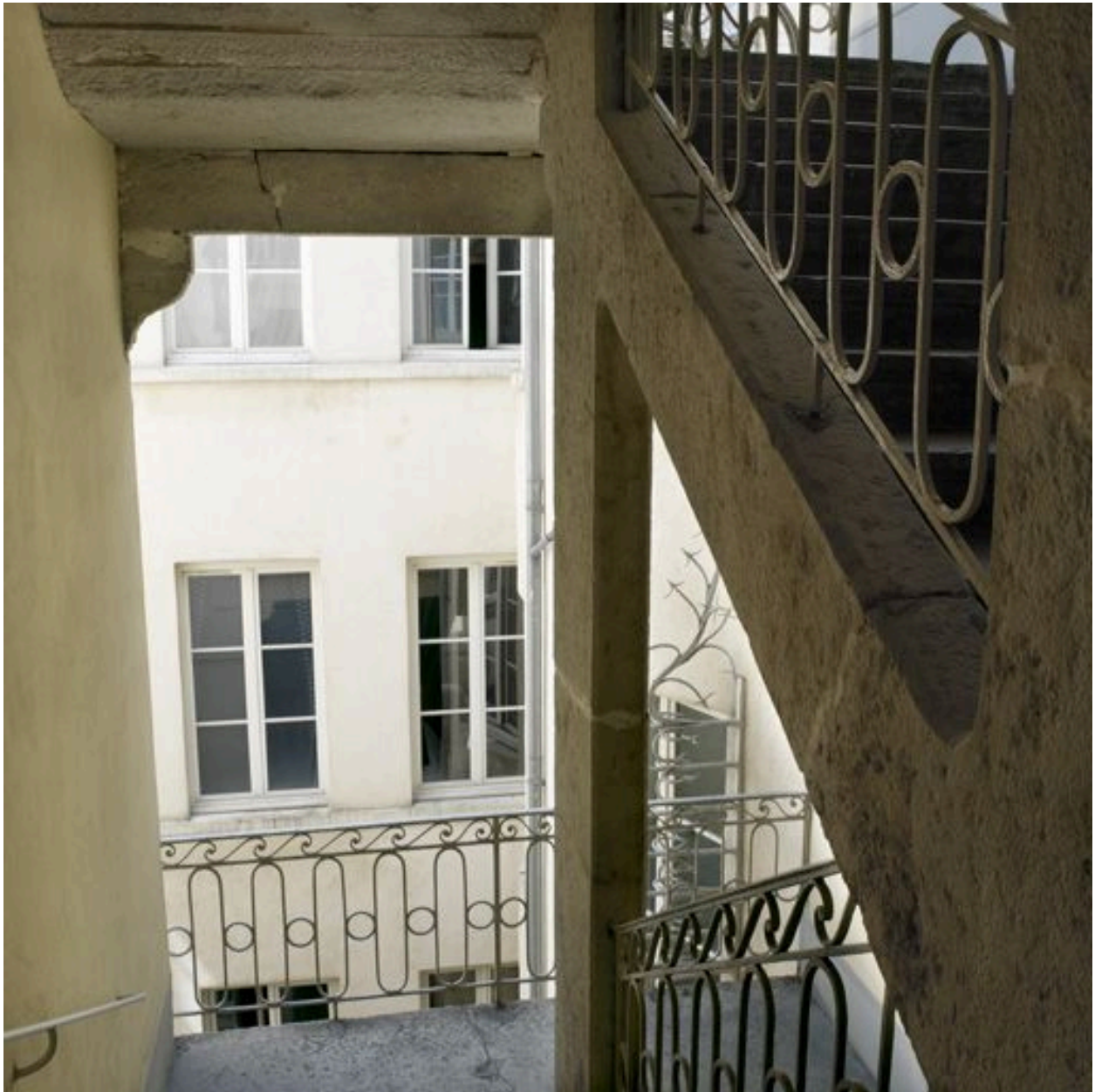
Escalier du premier corps, repos du troisième étage
