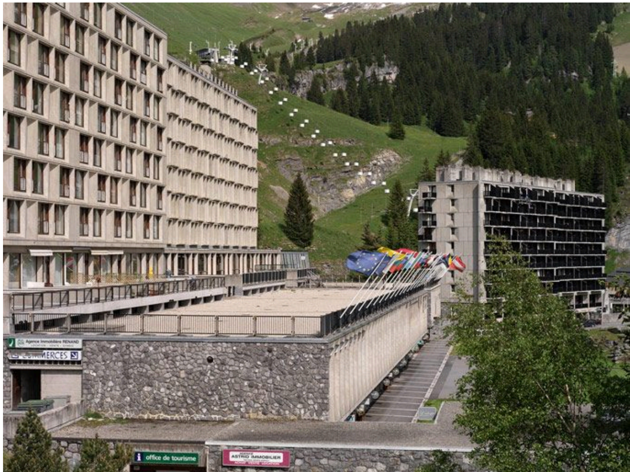
Vue générale depuis l'ouest-sud-ouest
