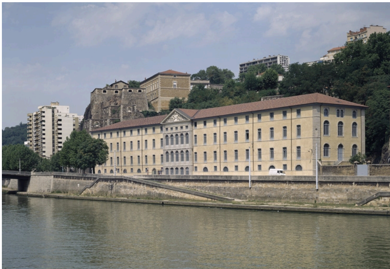
Vue générale, sud-ouest, façade principale
