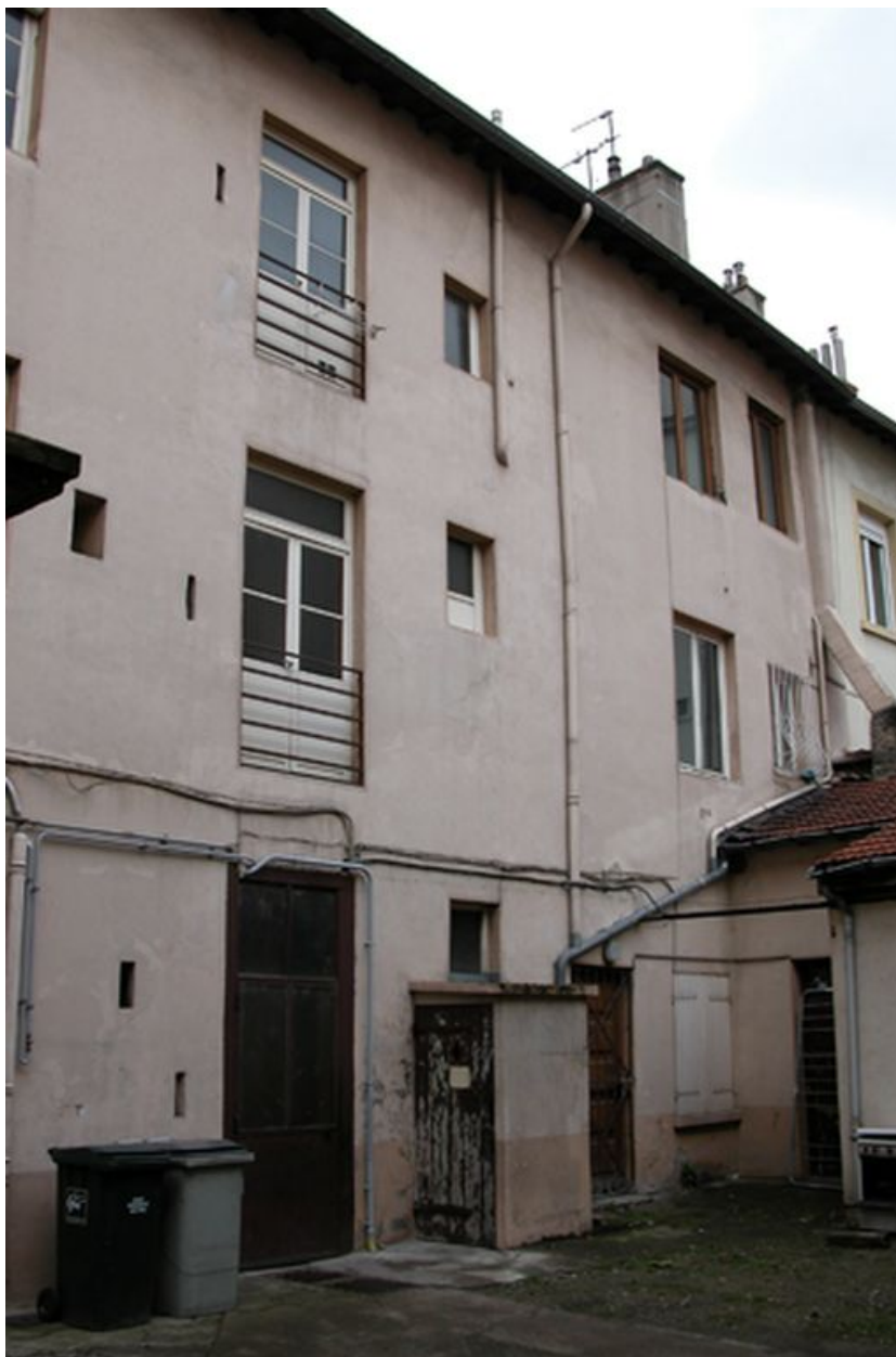
Elévation postérieure, partie ouest
