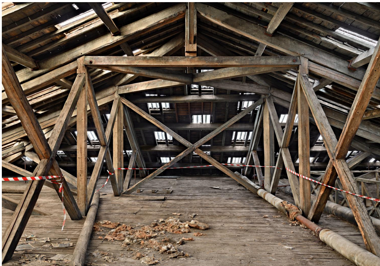
Détail élément de charpente
