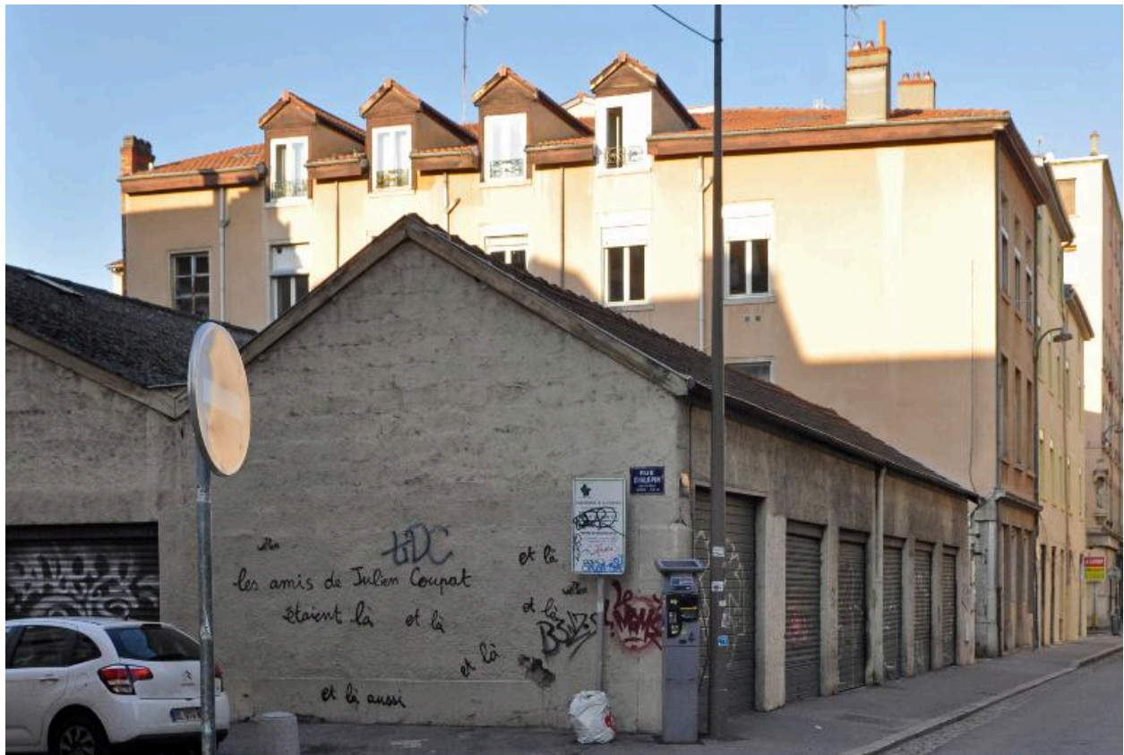
Vue d'ensemble depuis l'est, avant démolition des ateliers
