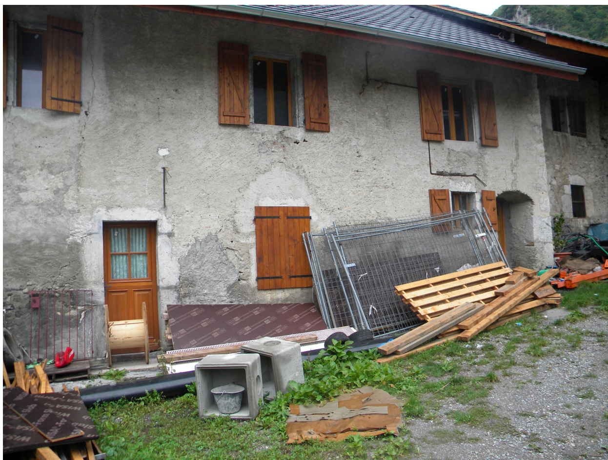
Vue du sud de la façade est.
