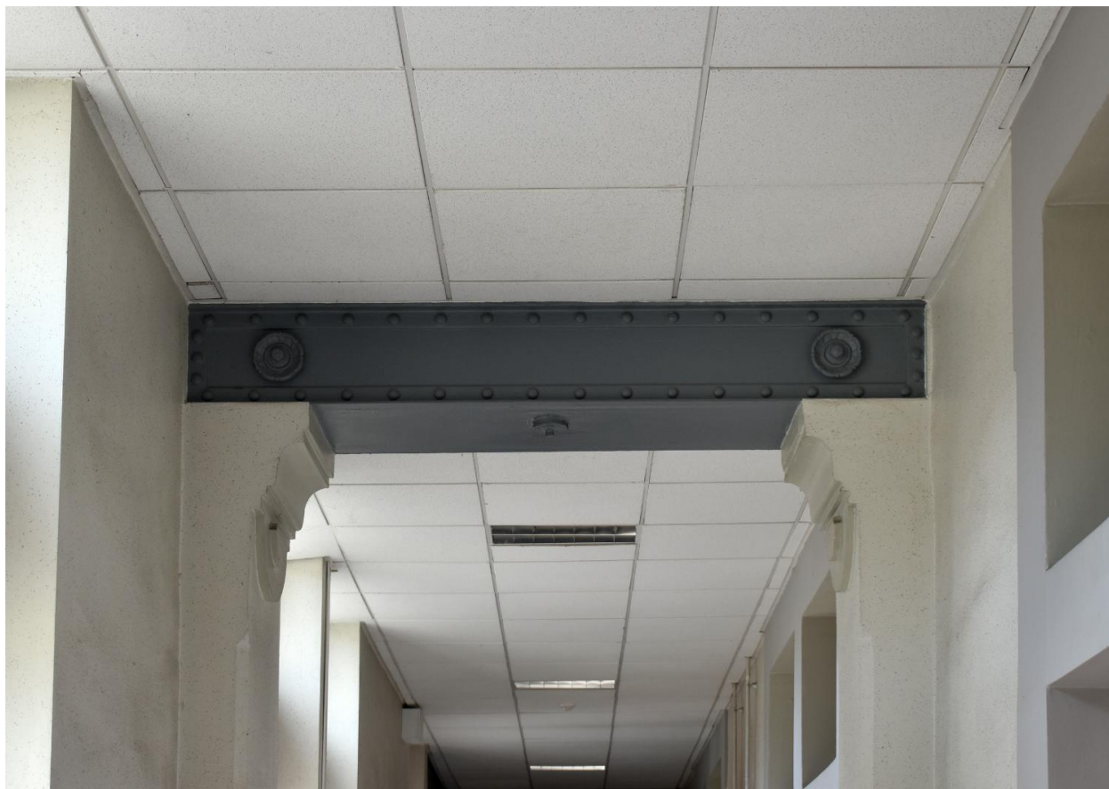
Bâtiment I : couloir du 1er étage, détail d'une poutrelle métallique
