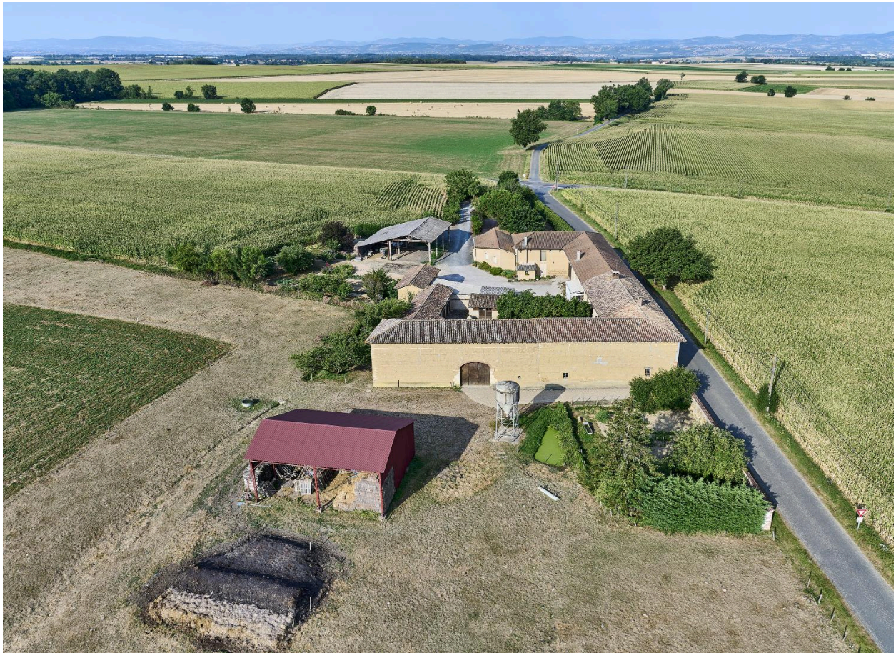
Savigneux, ferme de Grivel : vue aérienne
