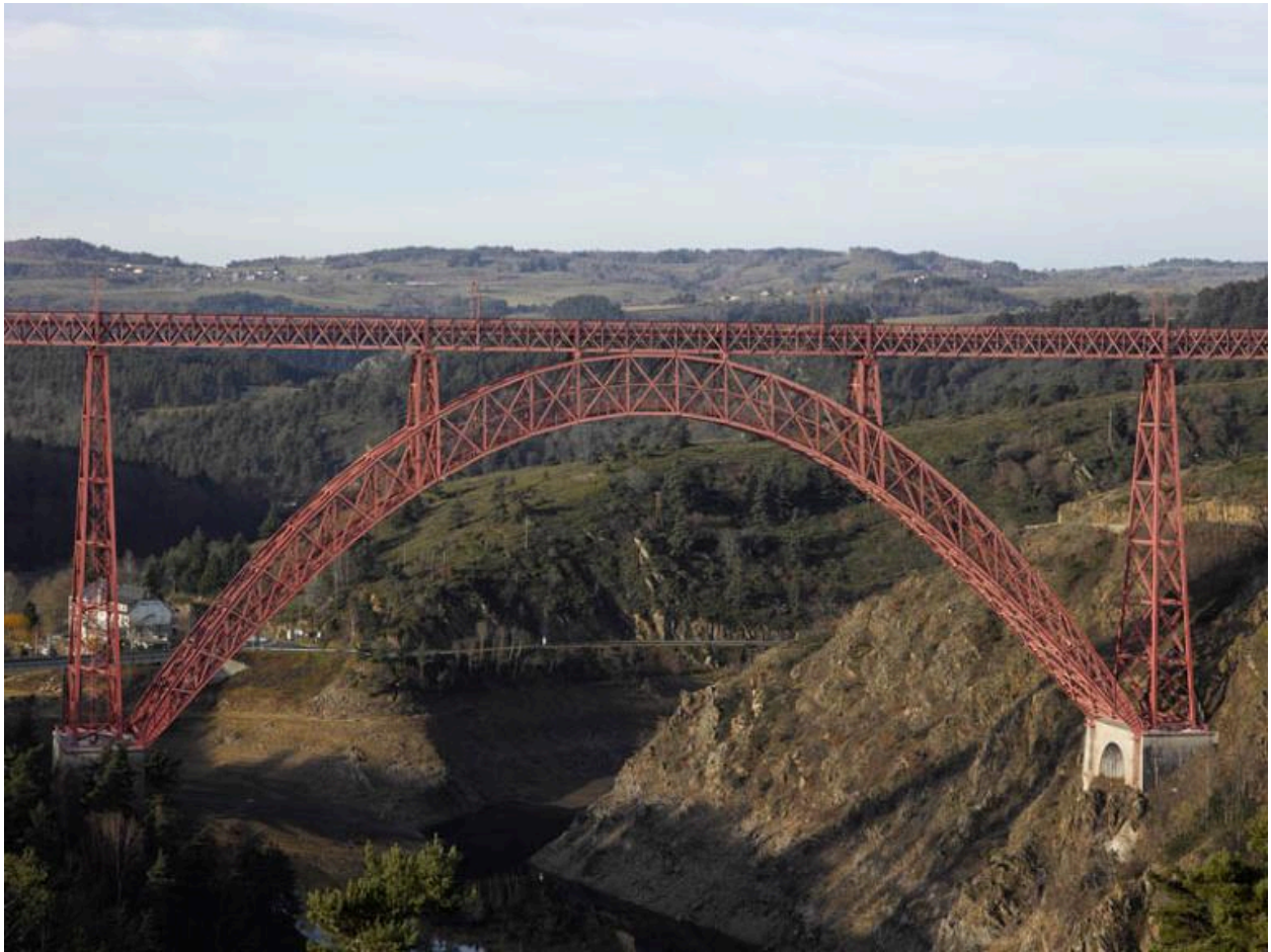
Vue sur la partie centrale du viaduc.
