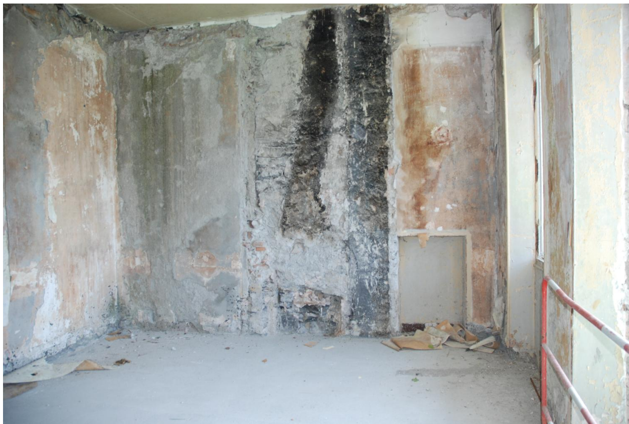
Vue intérieure du 1er étage : pièce sud.
