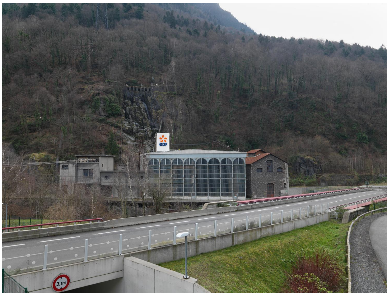
Vue d'ensemble de la centrale de Livet
