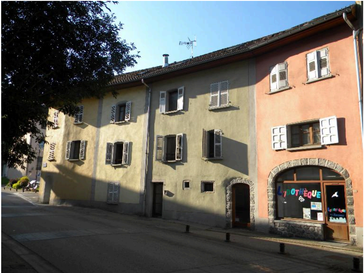
Vue de la partie est des façades principales.
