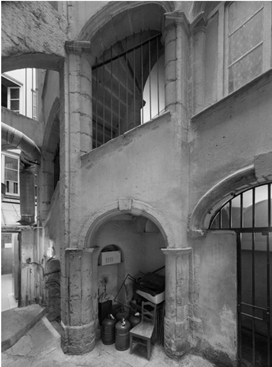
La cour : le rez-de-chaussée
