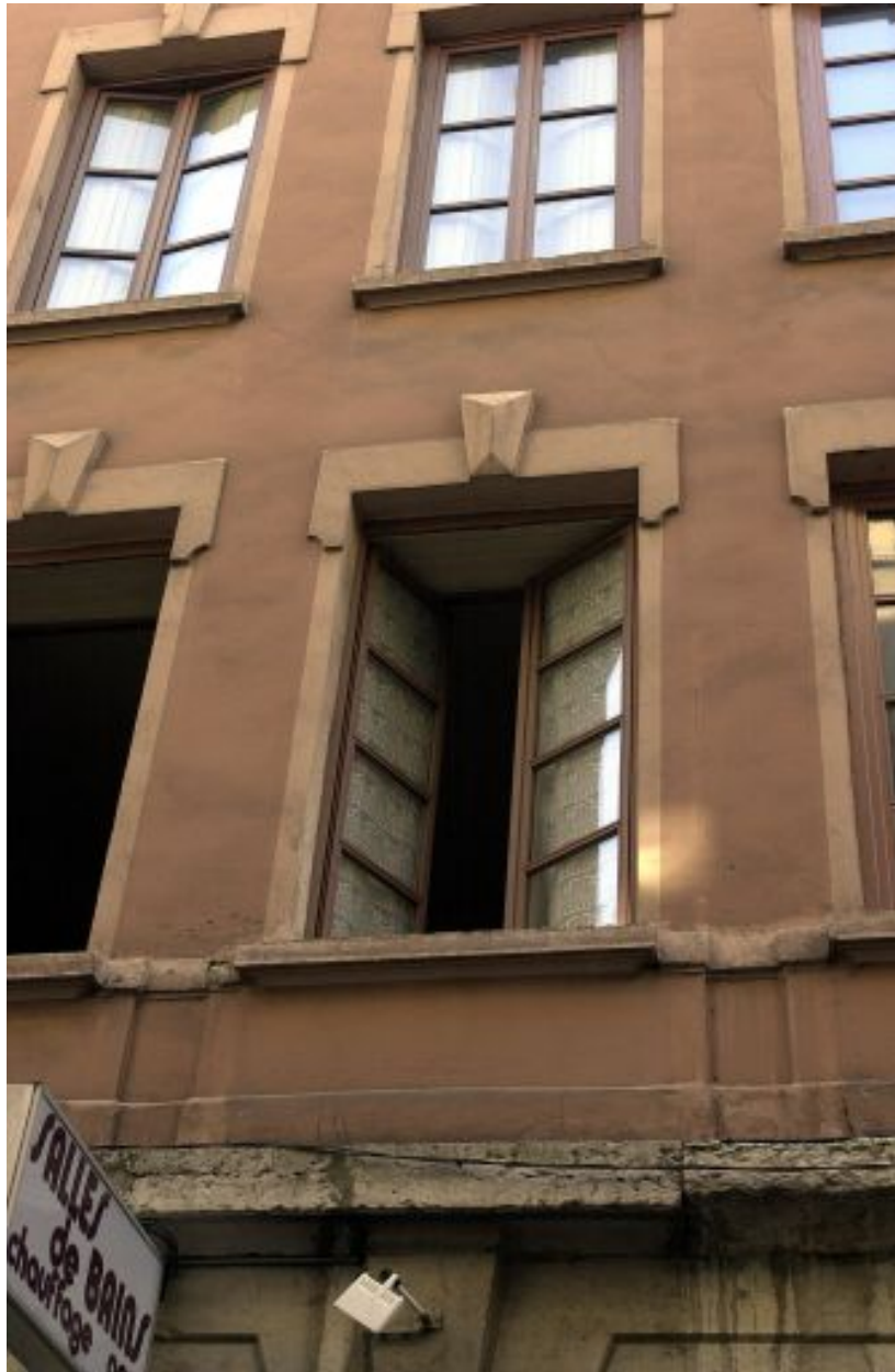
Façade principale sur la rue Lanterne, baie du premier étage
