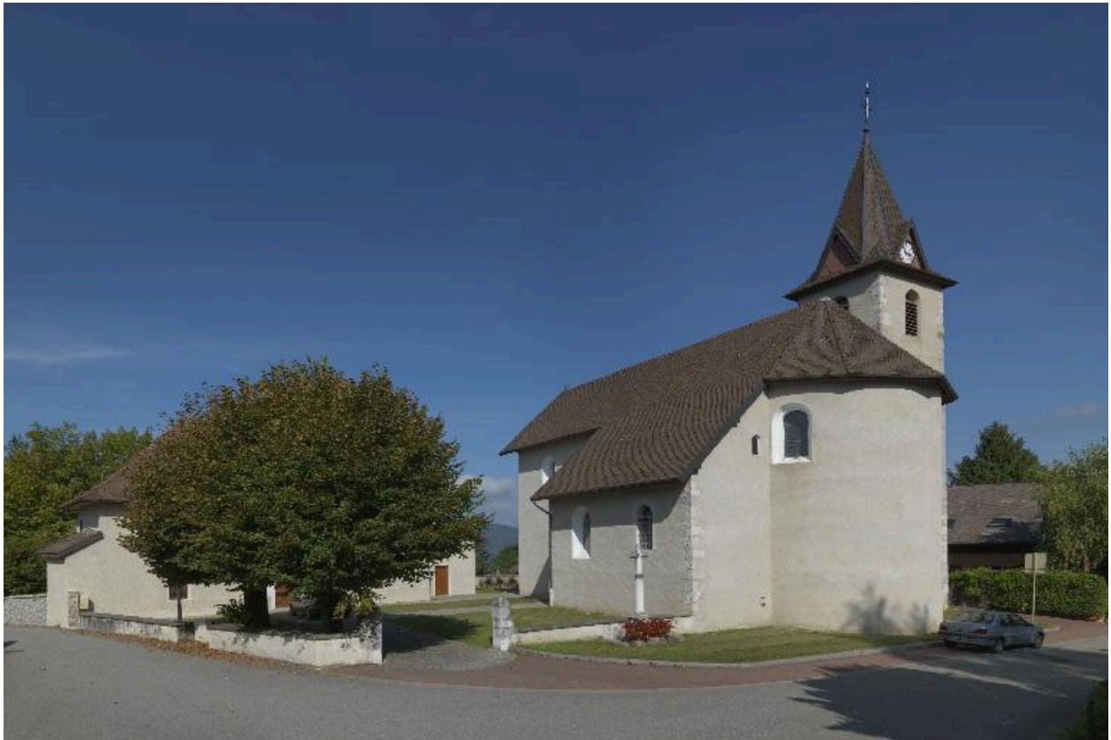
Vue d'ensemble de l'église (chevet) et du presbytère depuis le sud-est.
